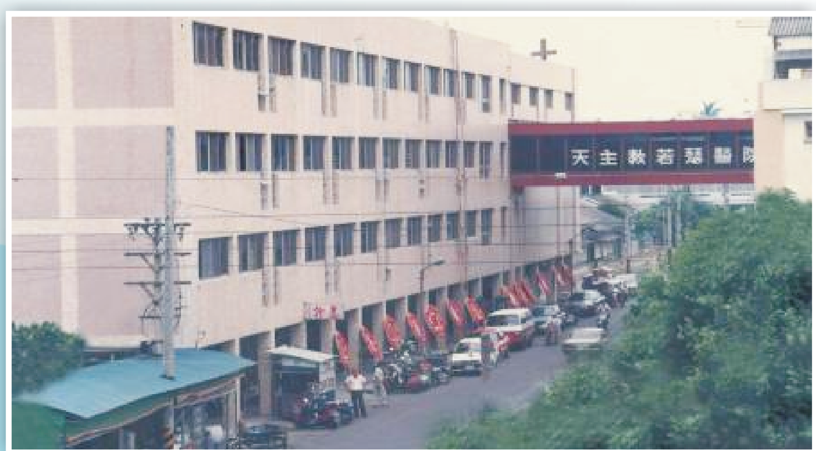
醫院三樓與宿舍天橋 (1984.09)
